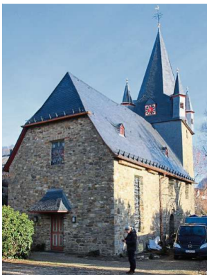
Seit zwei Jahren laufen die Sanierungsarbeiten an Dach und Kirchturm. Davon zeugen etwa die neuen kupferfarbenen Dachrinnen sowie die neuen Zifferblätter der Turmuhr. Foto: Sascha Valentini
